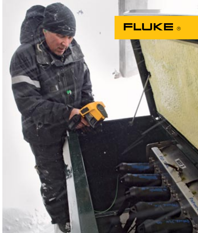
Суровые условия горнолыжного курорта Вистлер в западной части Канады не страшны тепловизорам Fluke.
